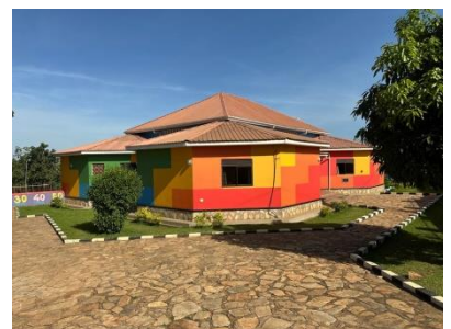
Nieuw dak kleuterschool
