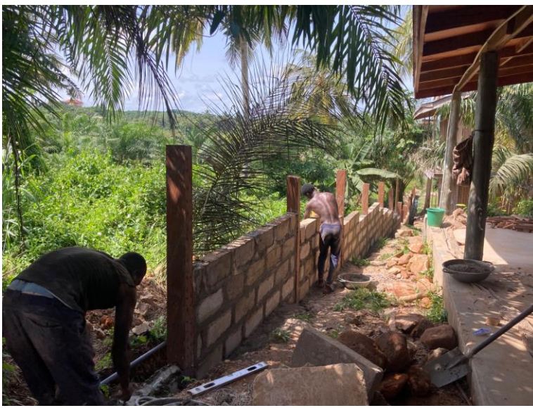
Metselaars aan het werk
