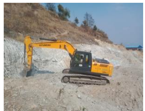
Aanleg speelplaats Nepal
