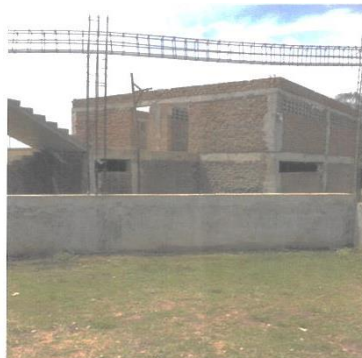
Bouw toiletgebouw Oeganda
