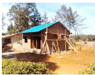
bouw ziekenhuis Kenia
