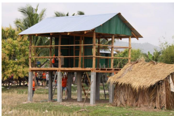
De oude huisvesting en de nieuwe (in aanbouw)
