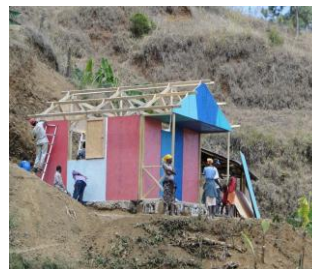
Bouw prefab huis in Haïti
