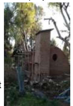
Eco-room in aanbouw
